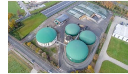
Mit dem Kauf einer Biogasanlage in Espelkamp investiert die Harting-Technologiegruppe in die unabhängige Gas- und Wärmeversorgung.
