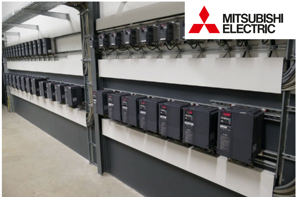
Ein Teil der räumlich von der Waschstraße getrennt angebrachten Frequenzumrichter.
